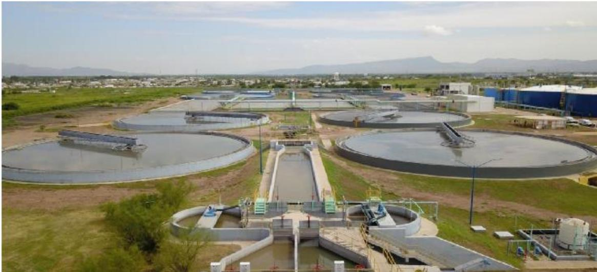
El agua proveniente del Cárcamo de Agua Cruda llega al Cárcamo Praderas TQ 100 que cuenta a la llegada con una reja tipo jaula de limpieza manual y polipasto para la remoción de basuras y sólidos grandes. Enseguida pasa al Pretratamiento que consiste en el desbaste y desarenado del agua antes de ser enviado al tratamiento primario.
